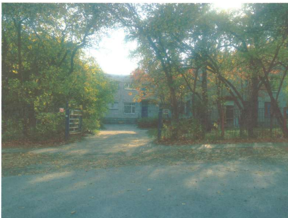
Подъезд к МДОУ № 36 «Василёк» со стороны ул. Текстильщиков
